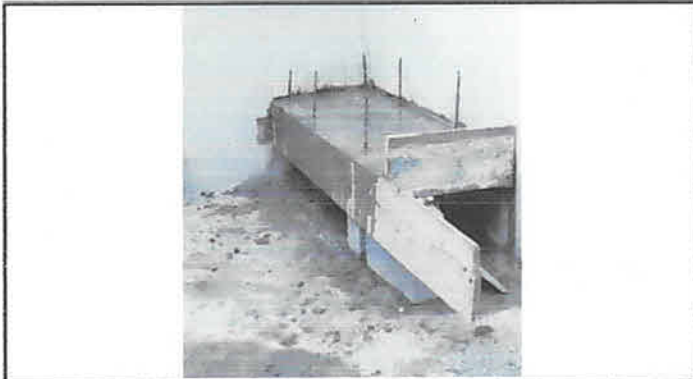
FOTO 1: ESTUFA ECONOMIZADORA DE LEÑA EN CONSTRUCCIÓN, CON BASES DE BLOCK Y PINES FUNDIDOS A LA MESA DE CONCRETO DONDE IRÁ LA CÁMARA DE COMBUSTIÓN FORRADA CON BALDOSA DE CERÁMICA.
