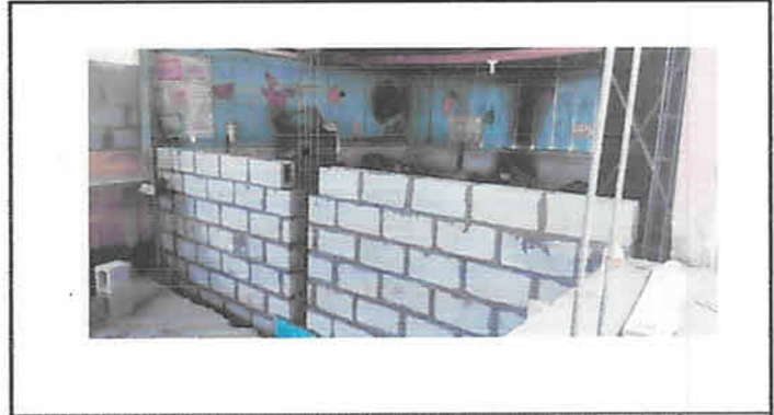
FOTO 4: PARA EL REMOZAMIENTO DE LAS PAREDES SE UTILIZÓ BLOCK NORMADO EL CUAL TENDRÁ UN ACABADO FINAL CON CERNIDO REMOLINEADO.
