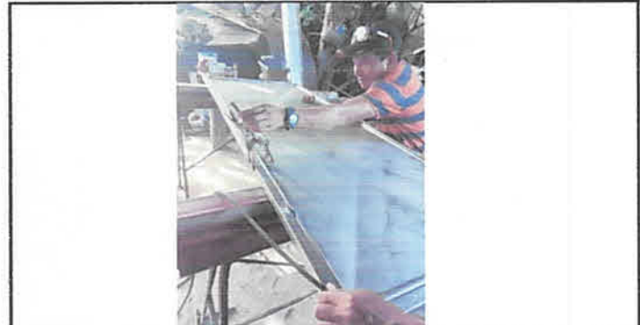
FOTO 6: PROCESO DE FABRICACIÓN DE LAS PUERTAS Y PORTÓN DE METAL.
