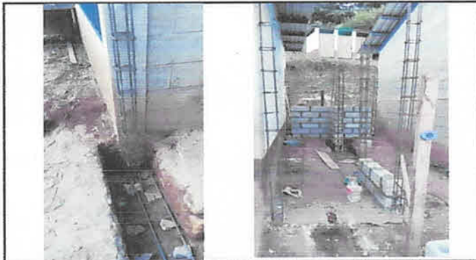
FOTO 3: LA ESTRUCTURA DE CONCRETO SE REFORZÓ CON HIERRO LEGÍTIMO Y LAS PAREDES QUE SE DEMOLIERON SE REFORZÓ DESDE LA CIMENTACIÓN HASTA LA SOLERA DE CORONA.
