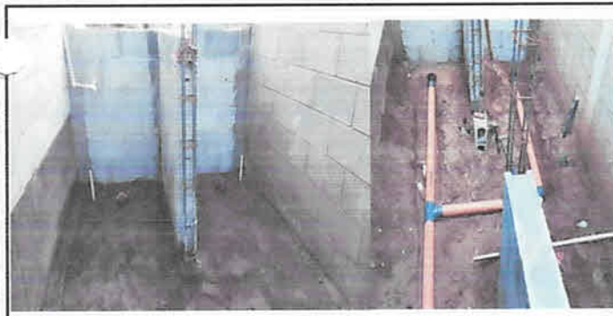
FOTO 5: DIVISIONES ENTRE LOS SERVICIOS SANITARIOS MODULADOS PARA LA UBICACIÓN DE TRES TAZAS SANITARIAS Y DOS LAVAMANOS.
